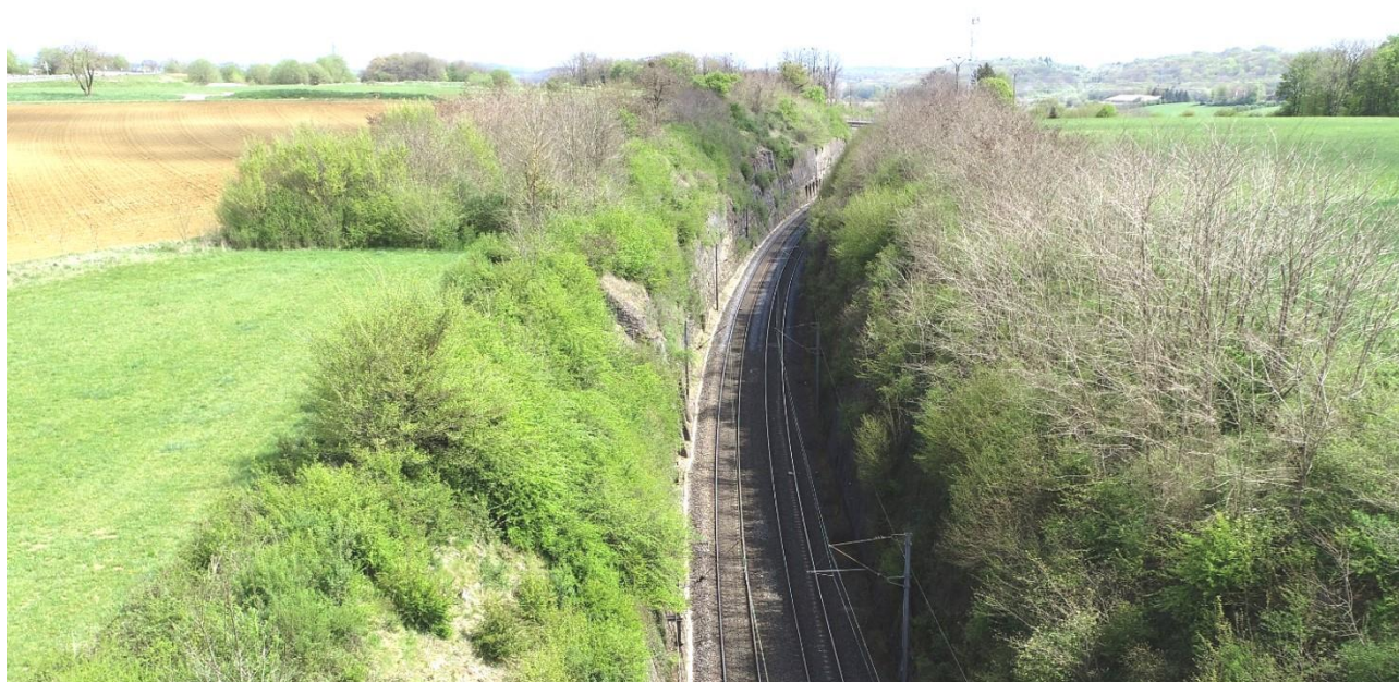
Travaux de confortement d'une tranchée rocheuse à Banvillars sur la ligne Dole - Belfort
