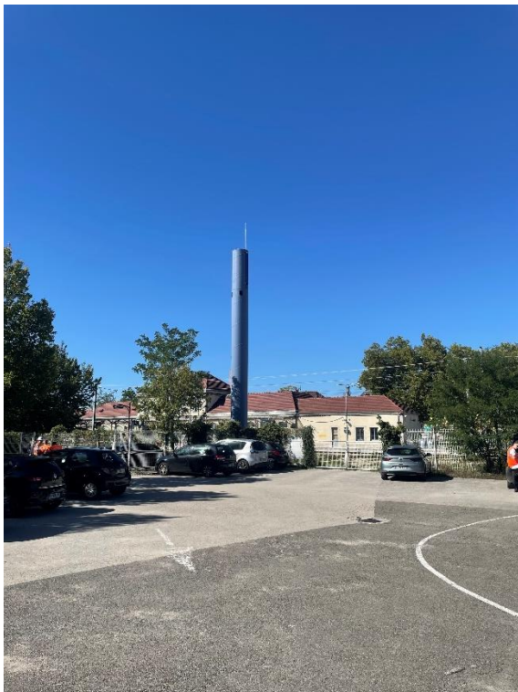
Installation du monotube à Lons-le-Saunier
