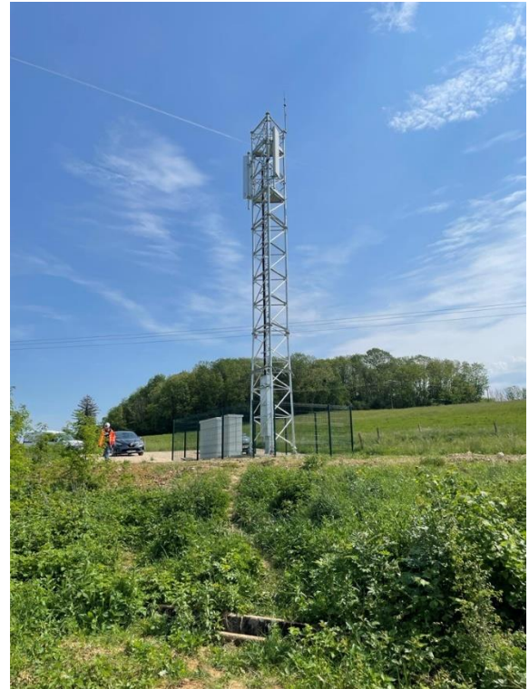
Installation du pylône à Frontenay
