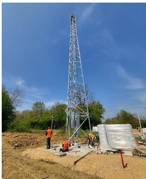
Installation du pylône à Champagnat
