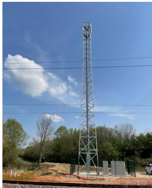
Installation du pylône à Poligny
