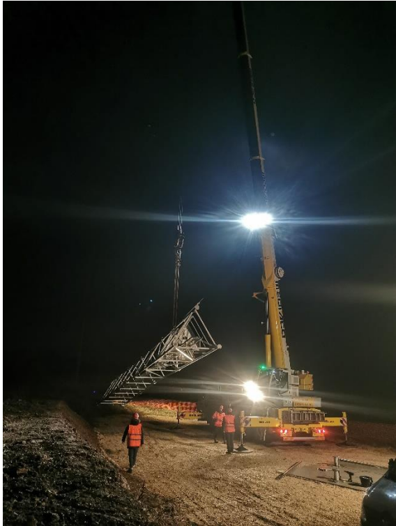
Élévation du 1er pylône à Arbois
