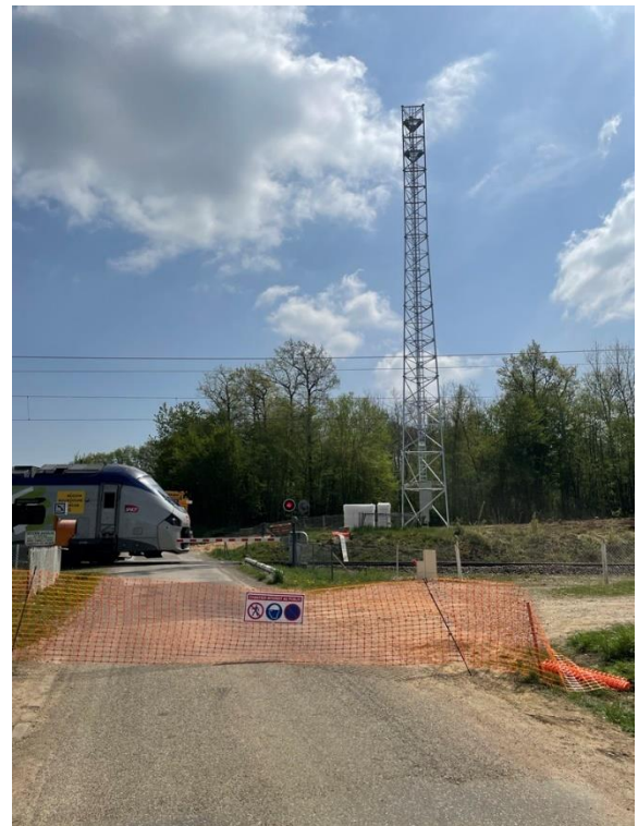
Installation du pylône à Champagnat
