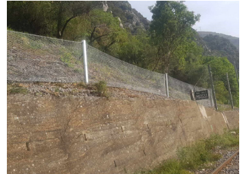
Confortement du versant de Gombes
