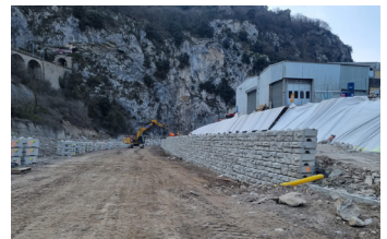
Travaux de confortement du SMIAGE au pied du viaduc d'Ambo
