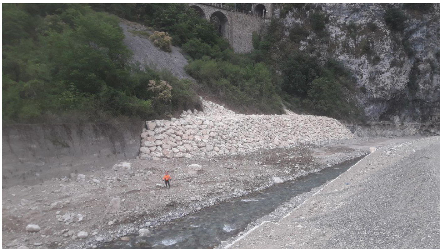
Enrochements au pied du viaduc d'Ambo
