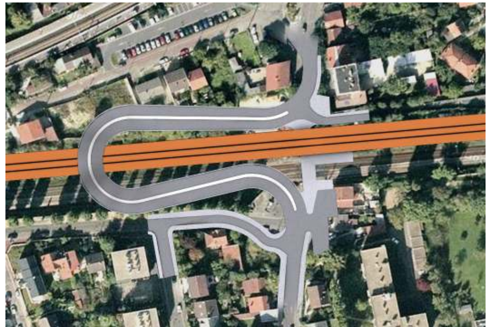
Pont-route en boucle
