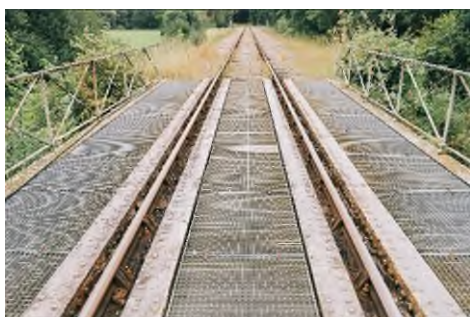
Pont-rail d'Esvres-sur-Indre Travaux du 29 novembre au 15 décembre
