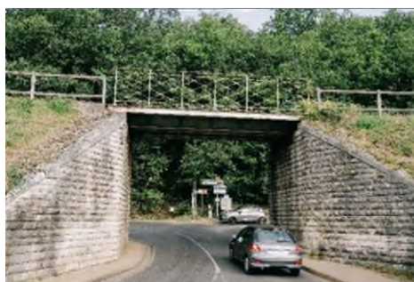
Pont-rail de Veigné Travaux du 6 au 22 décembre
