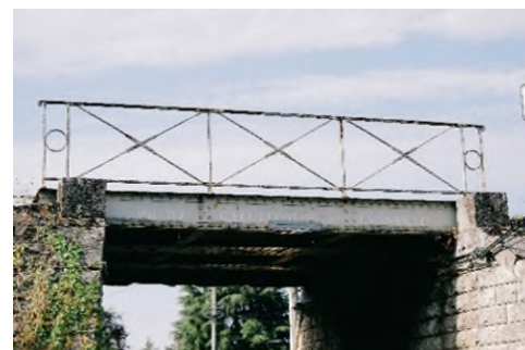
Pont-rail de Montbazon Travaux du 13 au 24 décembre
