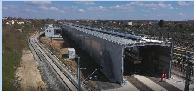
Exemple d'un site de maintenance (ajoutée post-réunion)
