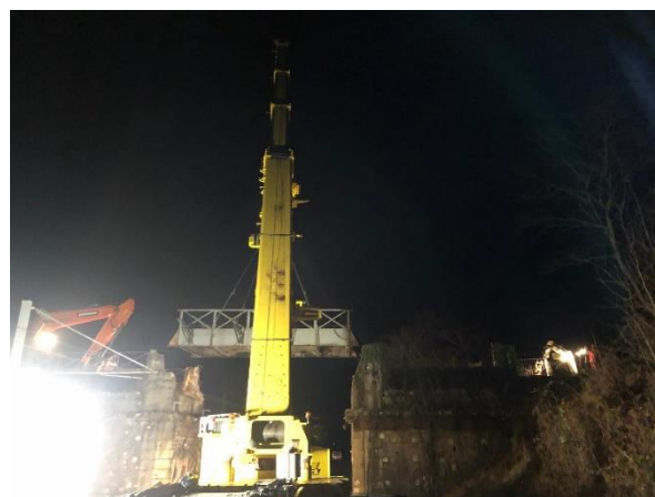
Levage du pont
