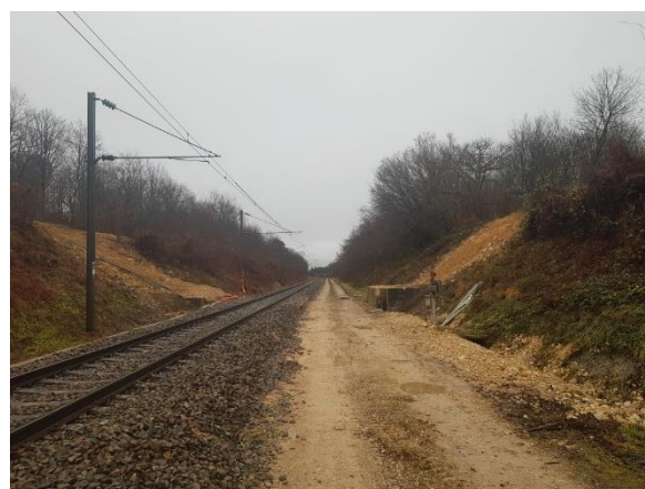
Vue de la ligne à la fin des travaux
