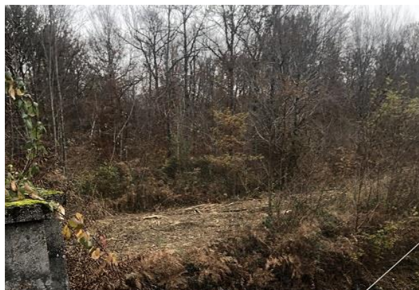
Débroussaillage des abords
