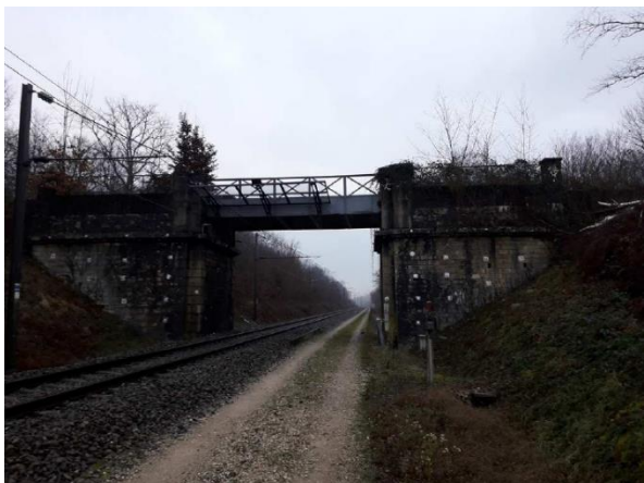
Pont à l'état initial
