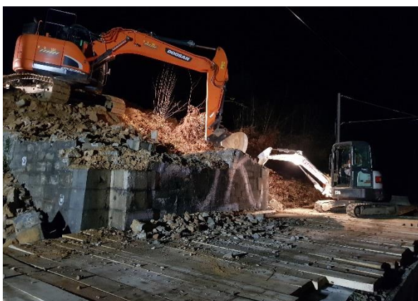
Déconstruction d'une culée du pont
