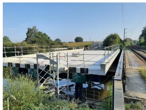
Le nouvel ouvrage de 450 tonnes est placé en parallèle de la voie ferrée avant sa mise en place définitive.
