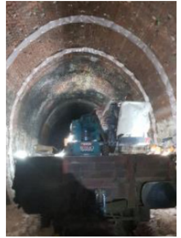
Travaux en cours dans le tunnel de Paganin
