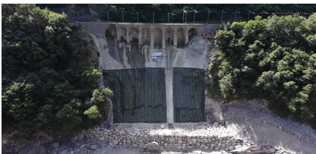
Vue aérienne du mur à arcatures à la fin du mois de juin - (c) SNCF Réseau - Jérémy Fanelli
