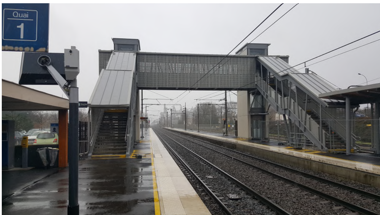
@SNCF Réseau, photos prises juste avant la mise en service
