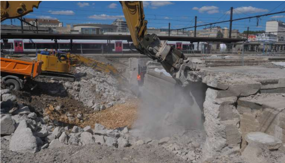
Démolition du souterrain permettant la construction des rampes
