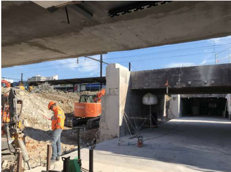
Terrassement et préparation avant pose des éléments préfabriqués de la cage d'ascenseur et de la rampe
