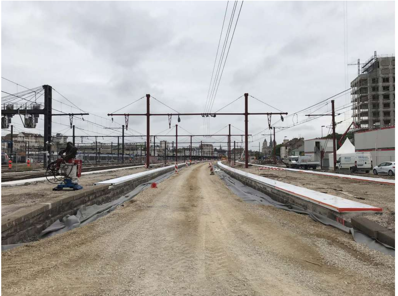
Voies H et I : piste servant à alimenter et à évacuer le chantier de génie civil - Pose des nouvelles dalles d'éveil en bordure des quais 4 et 5 avant pose des enrobés de quai (bitume)
