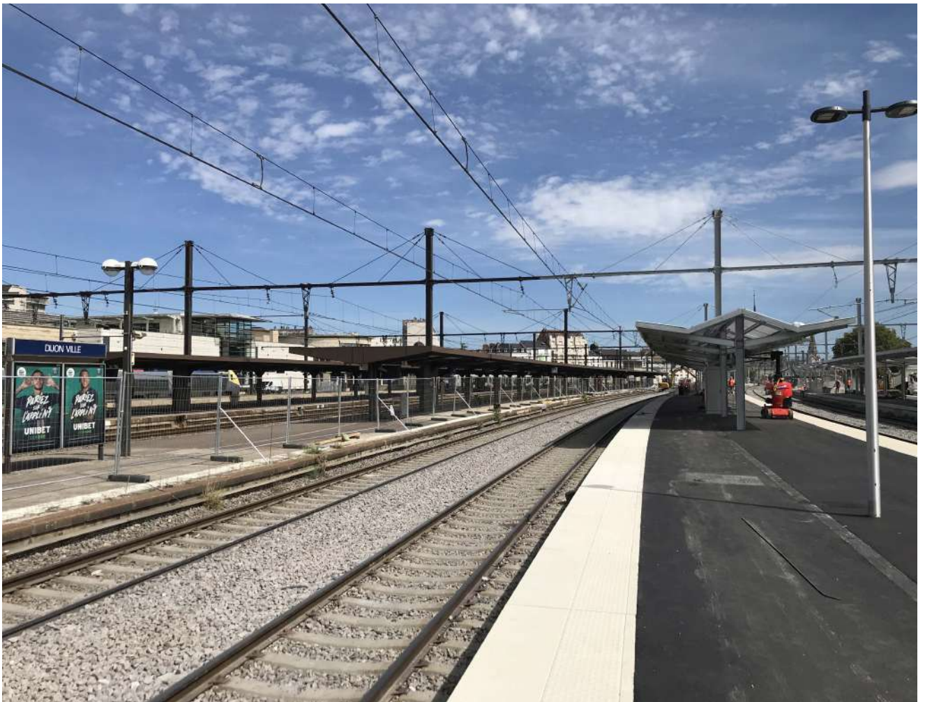
Nouvel abri voyageurs de 160 mètres de long avec bande translucide pour plus de luminosité sur les quais
