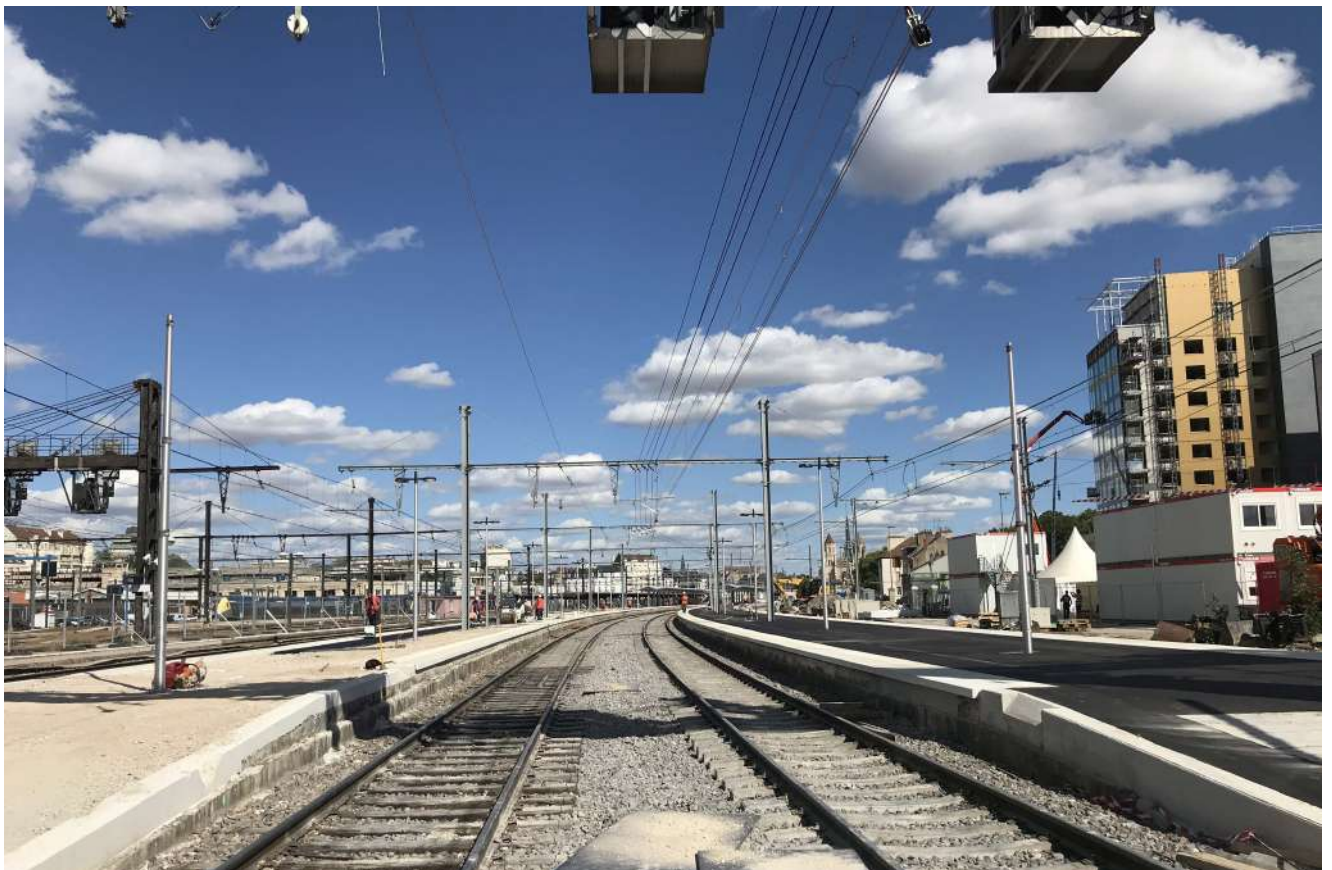
Remise en état des voies - Quai 4 : préparation avant pose des enrobés de quai (bitume) Quai 5 : pose des enrobés terminés - Mâts d'éclairage posés.
