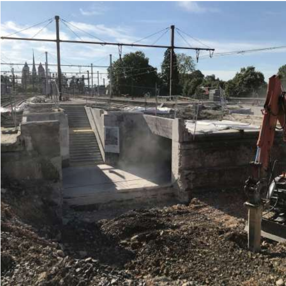
Terrassement et préparation avant pose des éléments préfabriqués de la cage d'ascenseur et de la rampe
