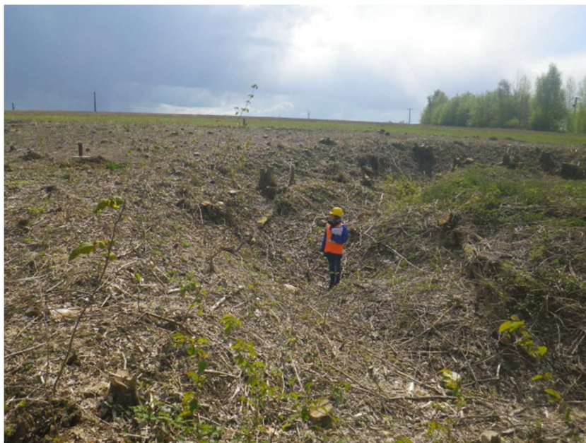
Brèche au-dessus du tunnel de Liart. Photo prise le 26 avril 2017
