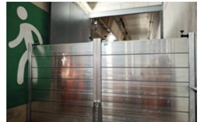
Montage des batardeaux (protection inondation)
