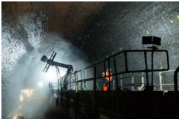
Décapage et le nettoyage de la maçonnerie existante.
