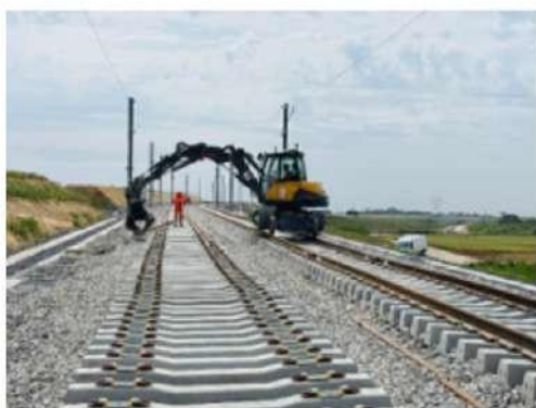
Pose de la voie sur la ligne nouvelle, Vémars Crédits : © Adonis Romdhane
