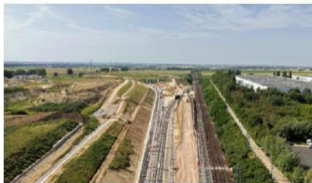
Zone de raccordement de la future ligne, Marly Crédits : © Potion MédiaTique
