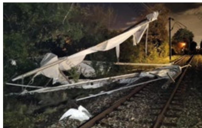
Dégâts causés par la tornade à Ermont le 20 octobre
