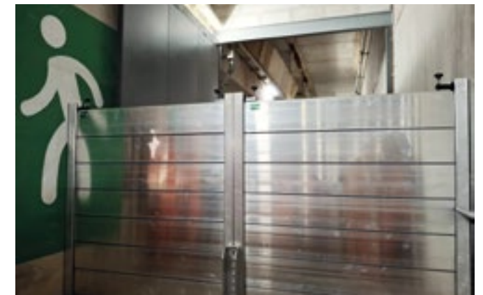
Montage des batardeaux (protection inondation)
