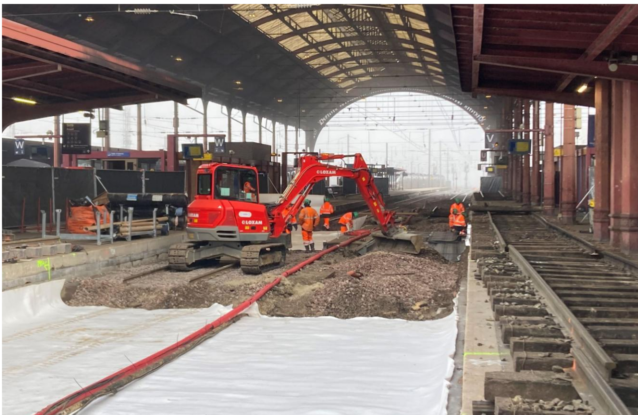
Chantier de remplacement d'aiguillage en gare de Strasbourg (©SNCFRéseau)
