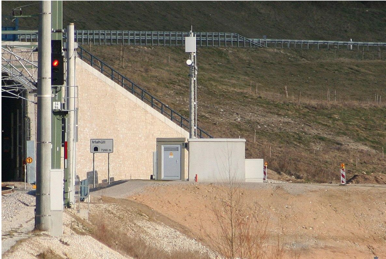
Mât d'émetteur de télécommunication ferroviaire
