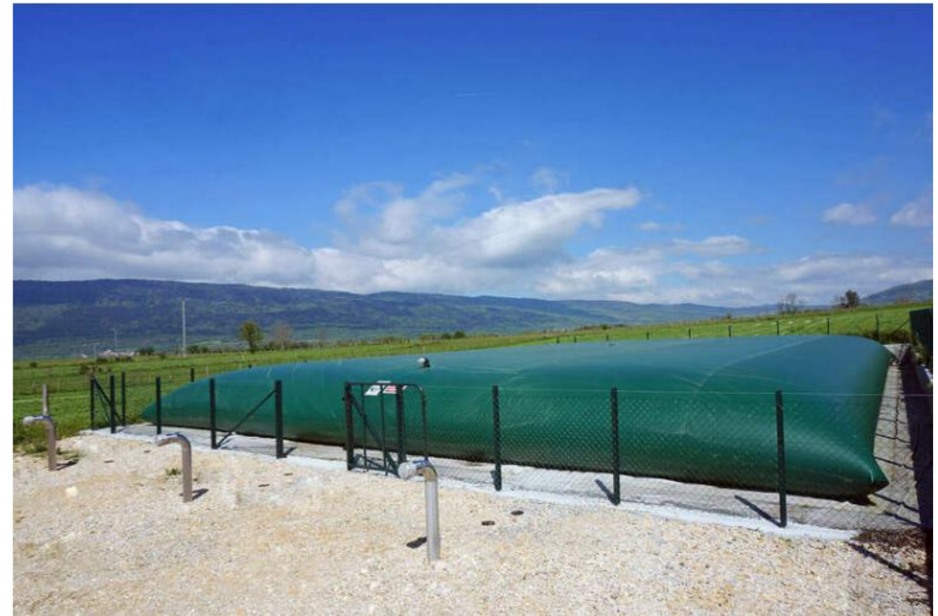
Exemple de réservoir incendie, source citerpack.com
