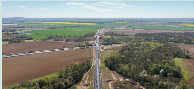
Plateforme ferroviaire qui accueillera bientôt la voie
