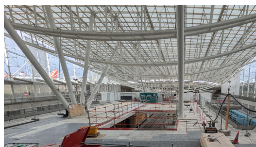
Création des accès au nouveau quai en gare Aéroport Charles de Gaulle 2 TGV
