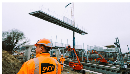
Pose de la future passerelle ville-ville en gare de Survilliers-Fosses
