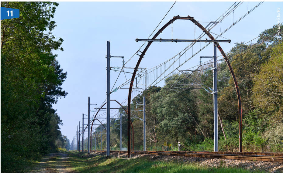
11 Coexistence entre caténaire « Midi » et nouveaux équipements (avant dépose des anciennes installations)
