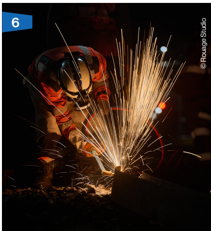
5 Découpage des supports d'ogive déposés
