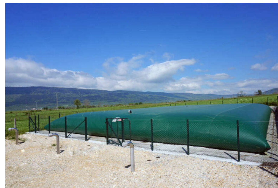
Exemple de réservoir incendie, source citerpack.com
