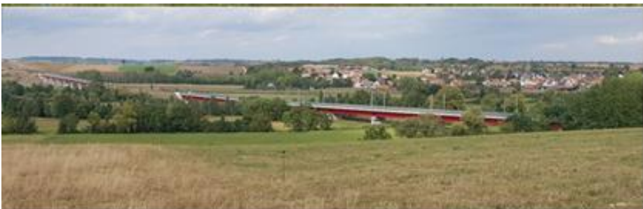
Viaduc de la Zorn en 2020 (©Egis)
