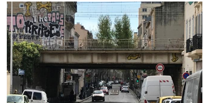
Vues du pont-rail de part et d'autre
