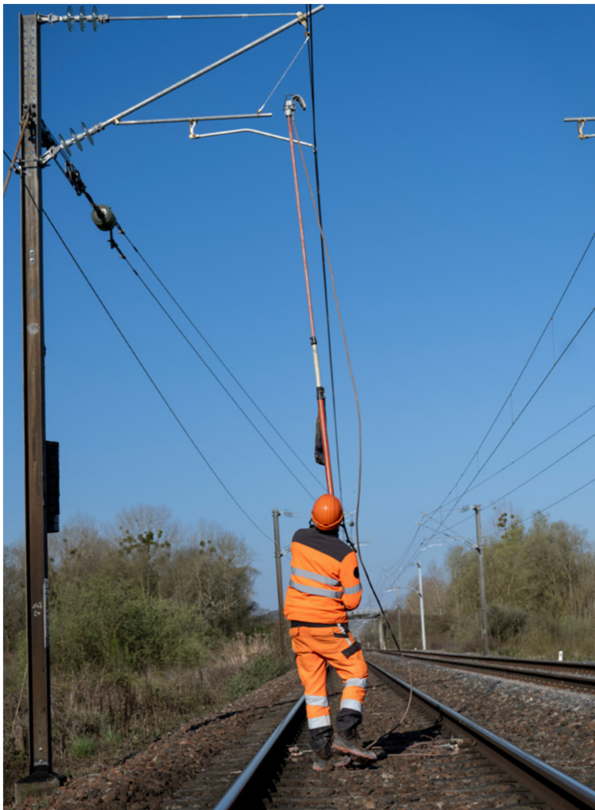
Travaux sur les voies : une fois que le courant est coupé, l'agent installe des équipements de sécurité pour éviter tout risque électrique pendant les travaux.
