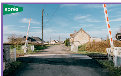
Remplacement du platelage et refecton de la route du passage à niveau situé rue du Moulin à Dercy
