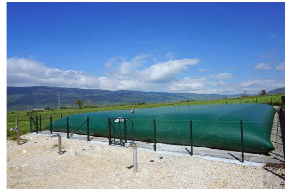
Exemple de réservoir incendie, source citerpack.com
