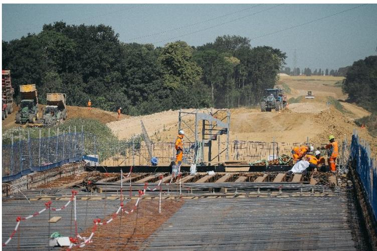
Travaux préparatoires du bétonnage du tablier du pont au-dessus de l'autoroute A1
