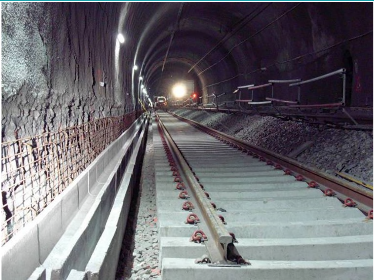
Prise de vue pendant les travaux dans le tunnel du Mont-Cenis
