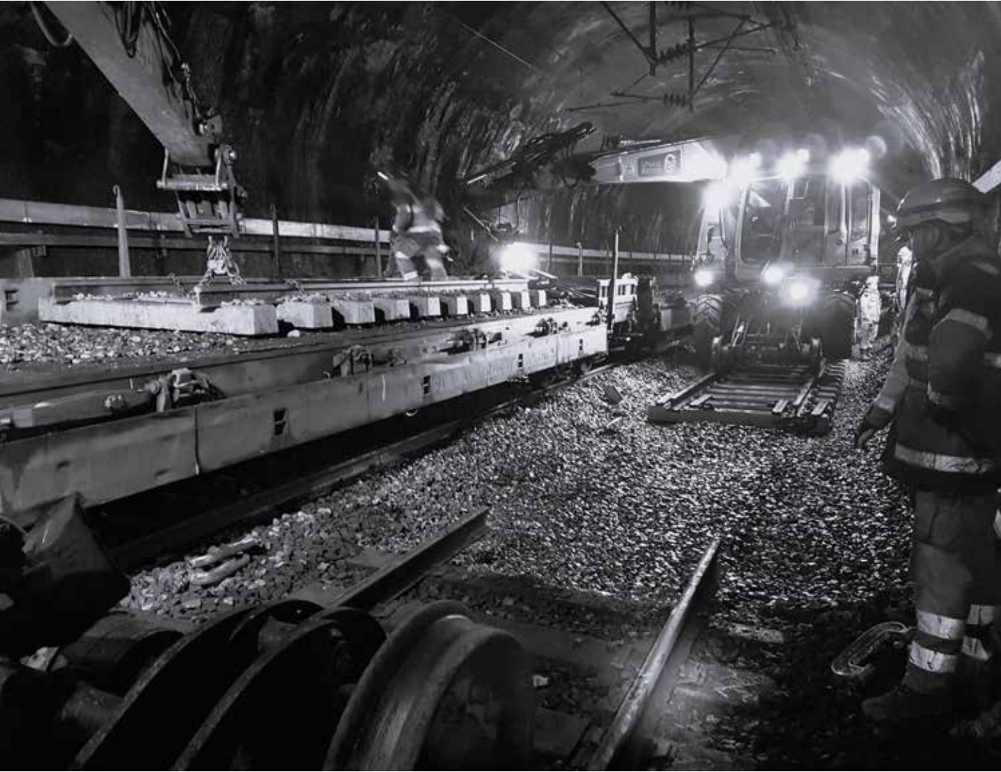
LE 3 ÈME PRIX A ÉTÉ DÉCERNÉ À JULIEN PUJOL DU PÔLE RÉGIONAL D'INGÉNIERIE À NANTES, QUI MAGNIFIE UN TRAIN DE TRAVAUX EN RECOURANT AU NOIR & BLANC.
