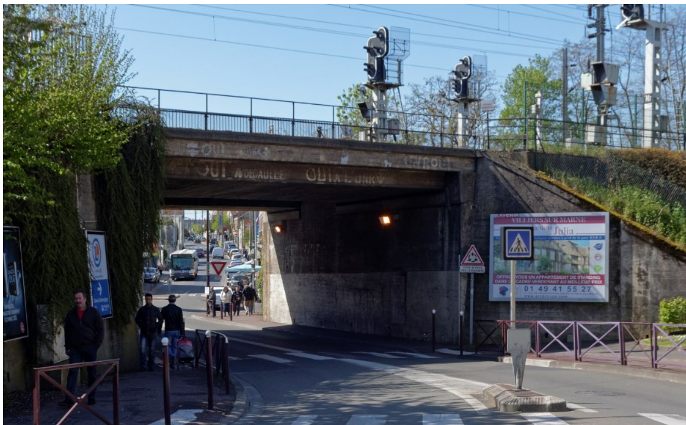
Figure 49 : Photo du pont-rail au niveau de la Rue du Général Leclerc
