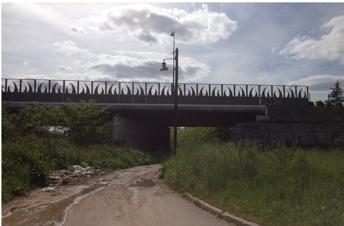
Figure 45 : Photo du pont-route du boulevard urbain Jean-Monnet (RD10)
