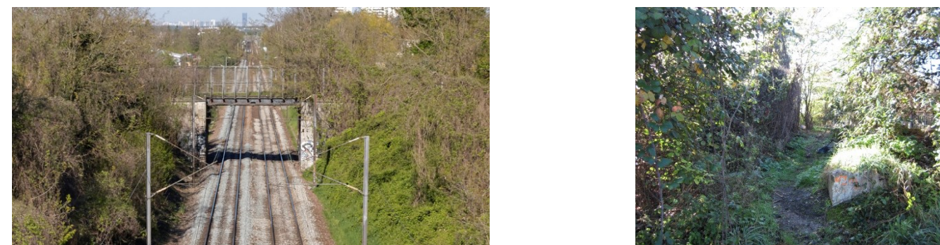
Figure 44 : Photo de la Passerelle dit du Pont des Portugais
