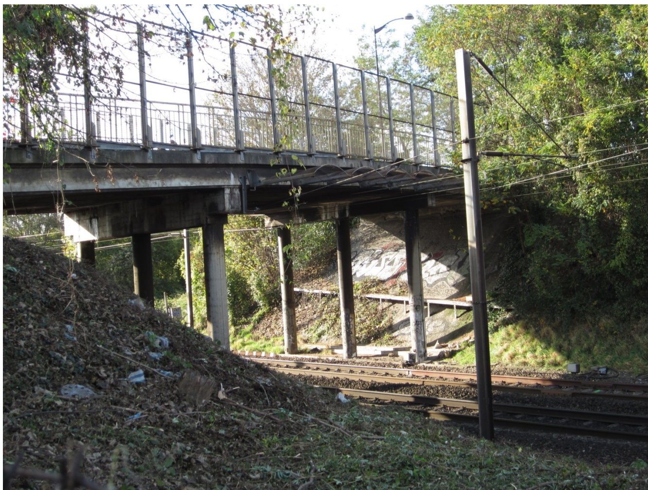
Figure 54 : Photo du pont-route au niveau de l'Avenue de Gaumont
