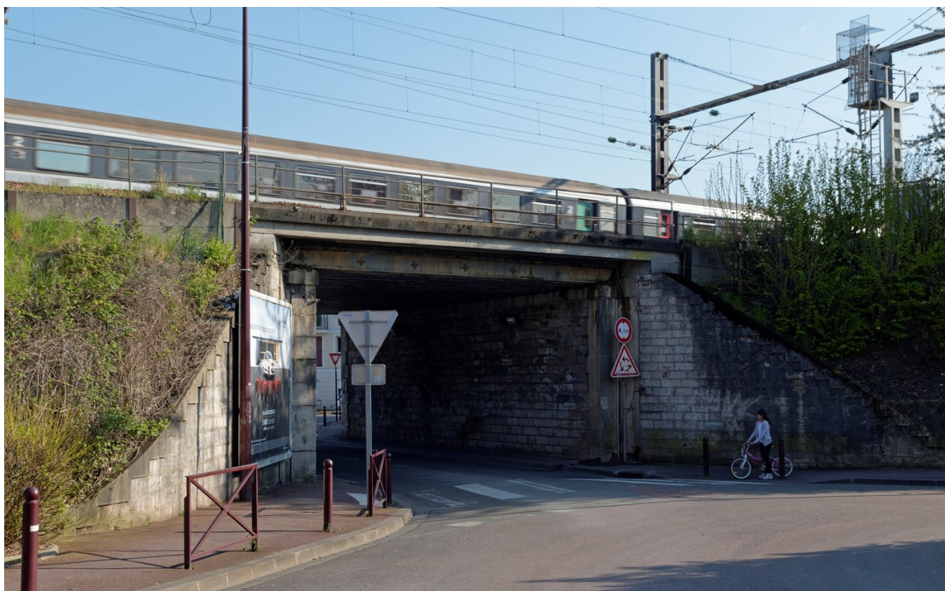
Figure 50 : Photo du pont-rail au niveau du Boulevard de Strasbourg
