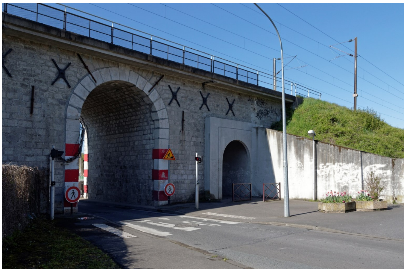
Figure 47 : Photo du pont-route maçonné au niveau de la Route de Champigny
