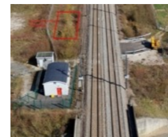
Figure 172 : Exemple de bâtiment de signalisation à démolir, © SNCF Réseau
