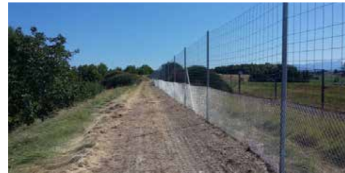
Figure 219 : Clôture de Type 5 avec grillage anti-fouisseur en partie basse, source : SNCF Réseau
