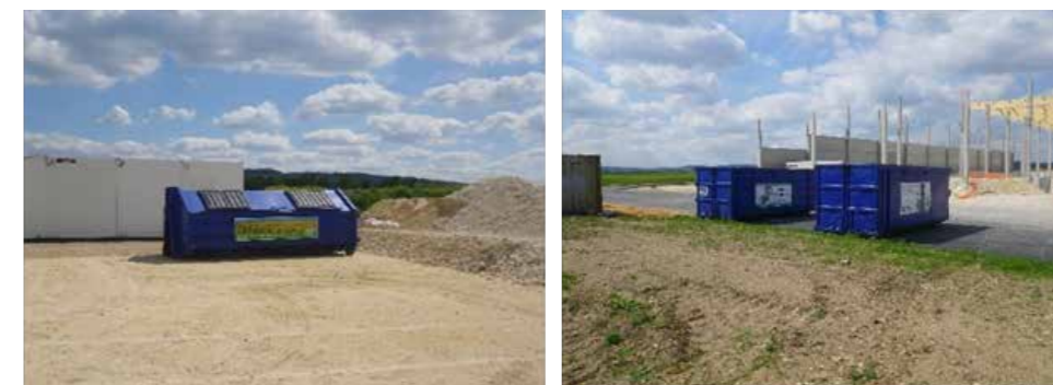
Figure 179 : Tri sélectif des déchets de chantier (@Biotope)
