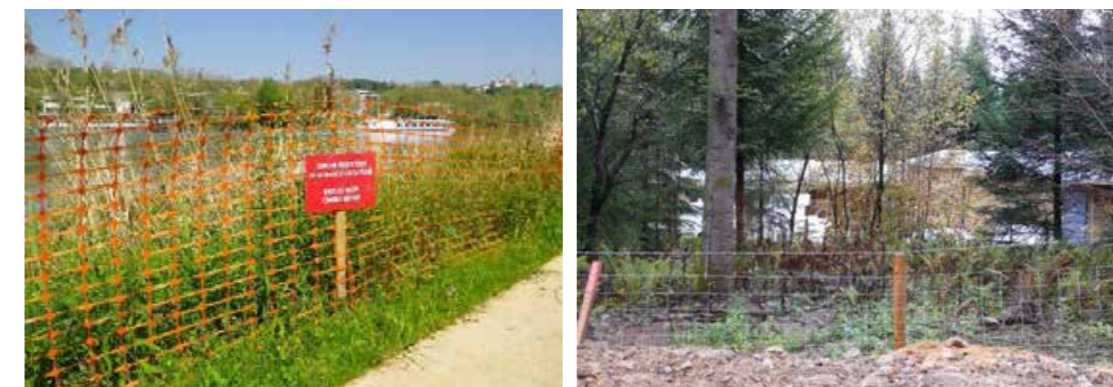
Figure 167 : Balisage d'une zone à enjeu (gauche) - Clôtures de chantier (droite), @Biotope
